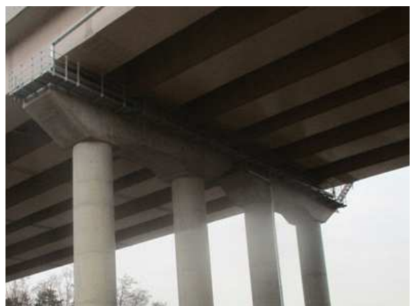
점검로 상태양호 - 금회
