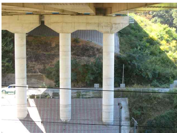
교각 상태양호 - 금회
