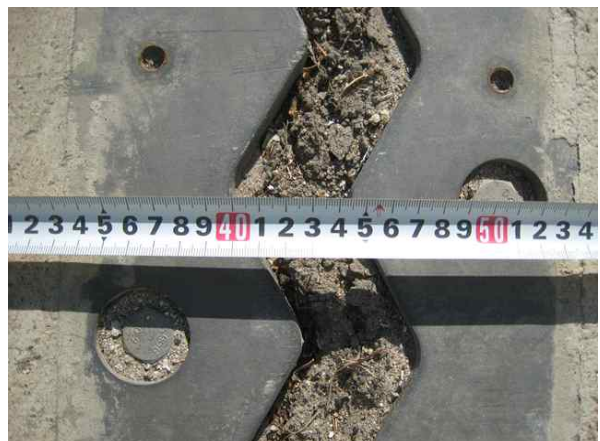
신축이음 이동량 측정
